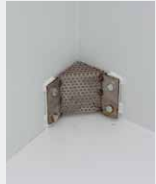
Sieb (Gitter) mit Ablasshahn, montiert
